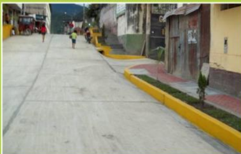
CONSTRUCCIÓN PISTAS Y VEREDAS JIRÓN RODRÍGUEZ TERCERA CUADRA
