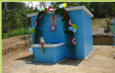
CONSTRUCCIÓN DE SISTEMA DE AGUA Y DESAGÜE NA PERLA OXABAMBA
