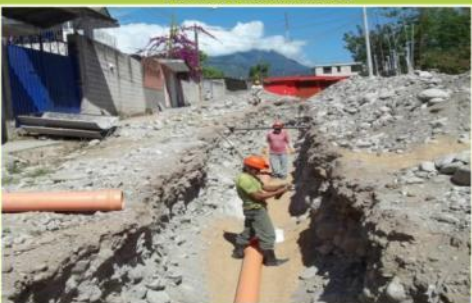
AMPLIACIÓN Y REHABILITACIÓN DE LA RED DE AGUA POTABLE Y ALCANTARILLADO DEL JIRÓN MERCADO CALLE MIGUEL GRAU, JIRÓN LAS PALMERAS
