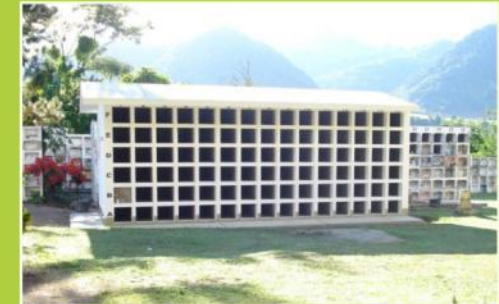
CONSTRUCCIÓN DE PABELLÓN DE NICHOS, ACCESOS Y VEREDA PEATONAL ADOQUINADAS EN EL CEMENTERIO
