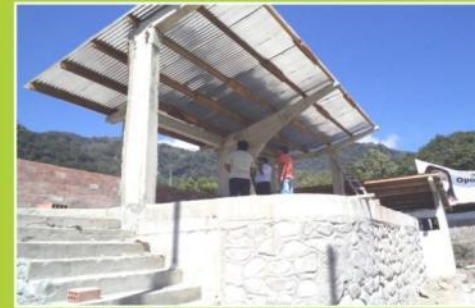
CONSTRUCCIÓN CENTRO COMERCIAL NARANJAL
