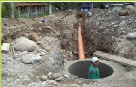
CONSTRUCCIÓN PISTAS Y VEREDAS PROLONG. CHANCHAMAYO CALLE SAN GENARO Y PROLONG. BEDOYA I ETAPA
