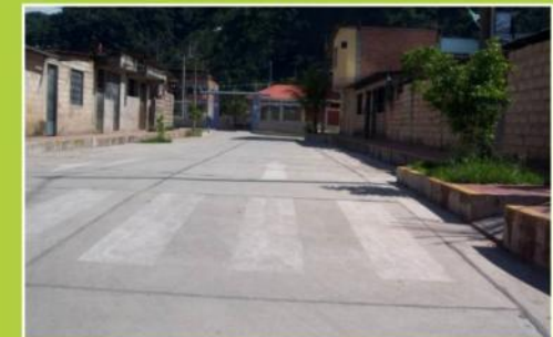
CONSTRUCCIÓN DE PISTAS Y VEREDAS CALLE 27 DE NOVIEMBRE Y 2 DE MAYO
