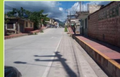
CONSTRUCCIÓN DE PISTAS Y VEREDAS CALLE LOS OROPELES, TRAMO AV. EL EJERCITO, CALLE A.A. CÁCERES
